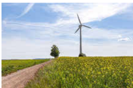
Windrad auf der Opitzhöhe in Freital. Ein Vorranggebiet bei Lübau sollte dreimal so hohe Anlagen ermöglichen. Foto: Stadt Freital
