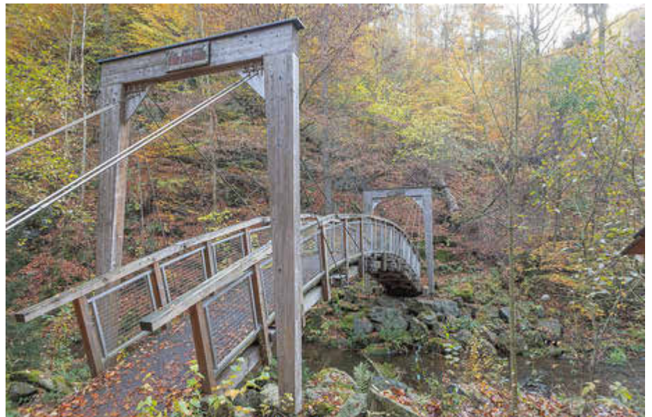
Die Arthur-Lohse-Brücke im Rabenauer Grund vor ihrem Abriss im Jahr 2023. Um einen Ersatzneubau wird derzeit gerungen. Foto: Stadt Freital
