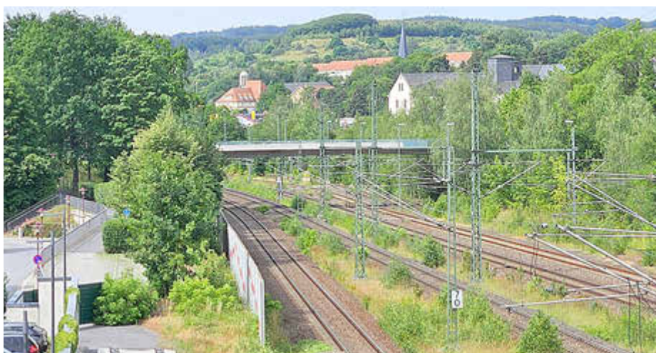
Die Fußgänger- und Radfahr-Brücke über die Bahn an der Gutenbergstraße muss abgerissen werden.
