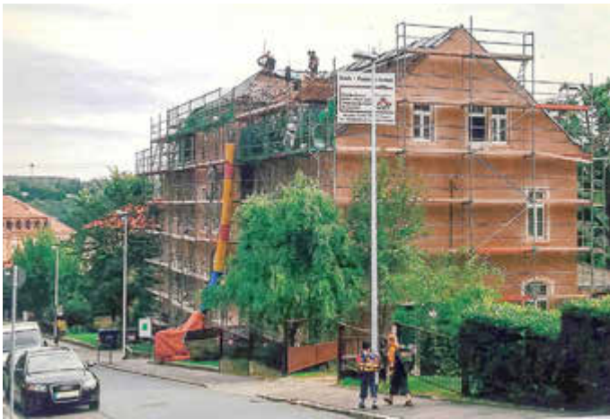
Dach- und Fassadensanierung 2007
