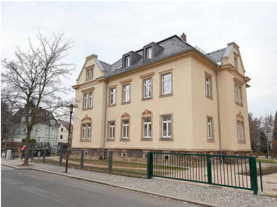
Die Kantstraße 7, ehemaliges Pfarrhaus, hat die Stadt Freital von der Kirche gepachtet und über Städtebauförderung saniert. Es beherbergt außerdem den die Nähwerkstatt des Förderkreis BIOTEC e. V. sowie Räume für die benachbarte Grund- und Oberschule.
