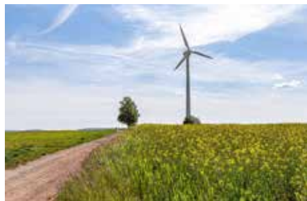
Windrad auf der Opitzhöhe in Freital. Ein Vorranggebiet bei Lübau könnte dreimal so hohe Anlagen ermöglichen. Foto: Stadt Freital
