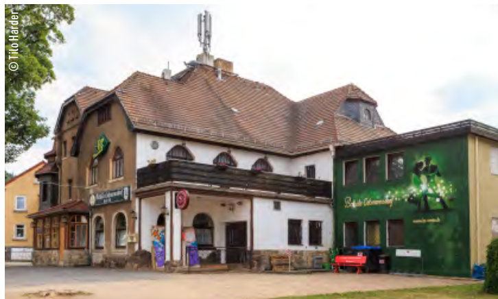
Das Gebäude der Ballsäle in Coßmannsdorf vor der Sanierung.
