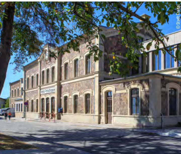
Der Bahnhof in Potschappel ist ein zentraler Ankerpunkt im Stadtteil. Das Gebäude wurde umfassend saniert und beherbergt seit 2019 unter anderem das Bürgerbüro der Stadt Freital.
