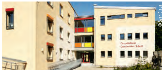
Grundschule Geschwister Scholl in Hainsberg
