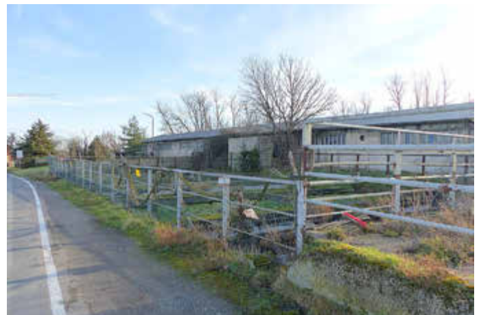
Das Areal befindet sich seit Jahren in einem schlechten Zustand. Leerstehende Gebäude, Ablagerungen, Müll und eine unregelmäßige Entwässerung prägten das Gelände. Dieser Missstand kann nun beseitigt werden. Foto: Stadt Freital
