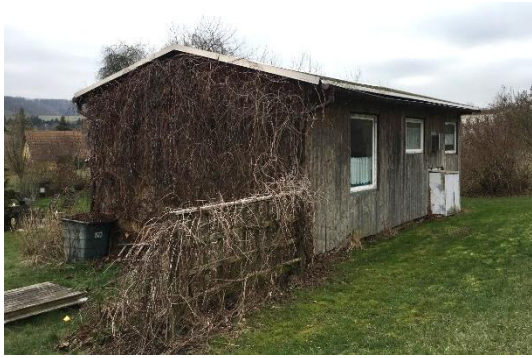
Abbildung 5: Gartenlaube auf Flurstück 71/2, Blick Richtung Westen (Aufnahme vom 24.02.2022)
